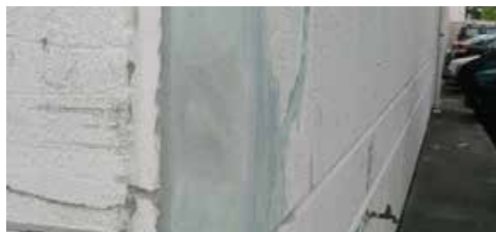
Belzona 4151 a été injecté avant de combler les fissures avec Belzona 4111.
