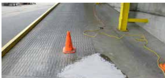
Le système Belzona 4151 + 4111 a été utilisé pour reconstruire et lisser la zone fissurée.
