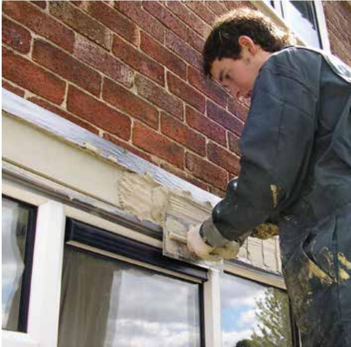
Belzona 4141 (Magma-Build) est un composite de réparation bi-composants léger pour la reconstruction des surfaces verticales et en hauteur endommagées. Ce système épais simplifie les applications tout en conférant une protection à long terme.
