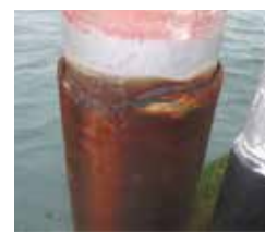
Matériaux différents liés par un joint étanche
