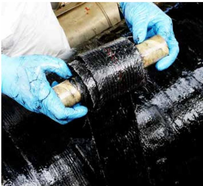
Belzona SuperWrap II est une solution de réparation composite qui peut restaurer la force des substrats métalliques affaiblis ou troués. Il a été développé pour les applications sur les tuyaux et les cuves de procédé, et convient aussi aux systèmes critiques et sous pression. Il peut être utilisé sur les coudes, les T et les autres géométries complexes.
