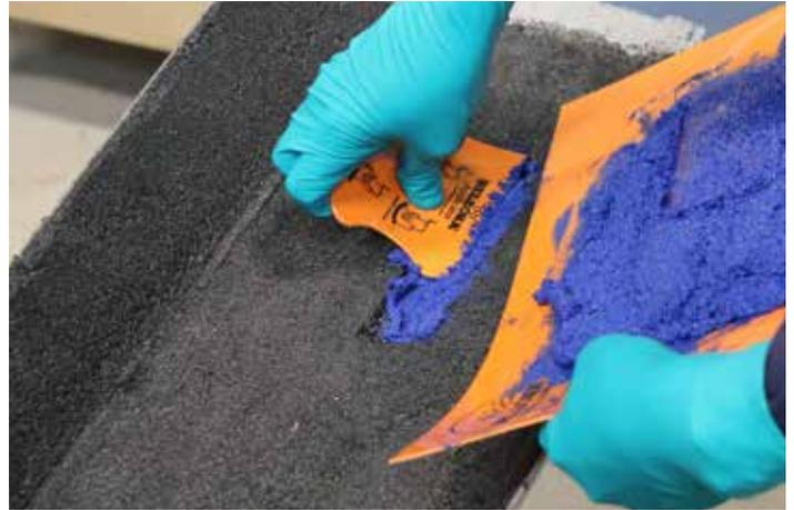
Comme indiqué dans l'illustration ci-dessus, Belzona 1818 convient idéalement aux réparations par plaques où un retour en service rapide est nécessaire.
