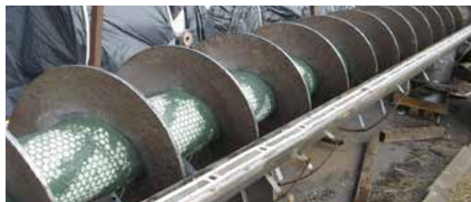
Convoyeur à vis réparé avec Belzona 1813 et des carreaux en alumine
