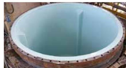
Les couleurs claires de Belzona 1593 facilitent l'inspection visuelle des cuves.
