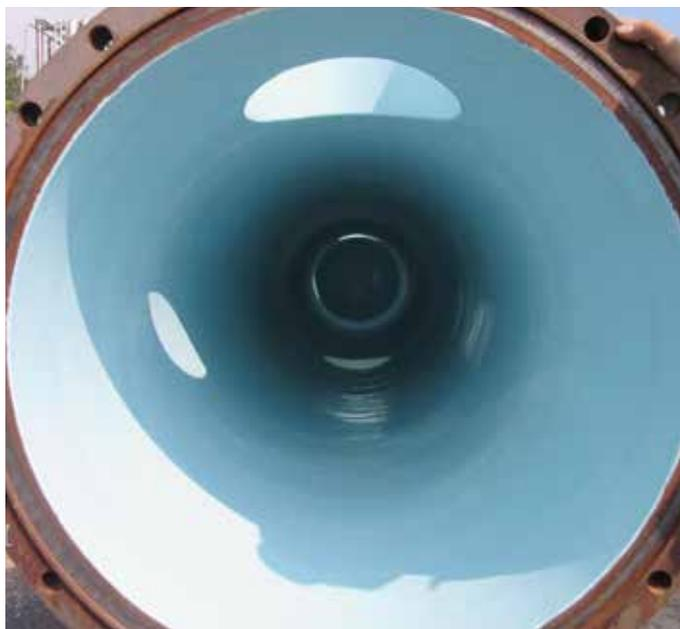
Belzona 1593 est un revêtement haute température qui convient à l'équipement fonctionnant en immersion continue dans les systèmes aqueux et d'hydrocarbures, à des températures inférieures à 160 °C (320 °F). Il confère une excellente résistance à la corrosion et à de nombreux produits chimiques.
