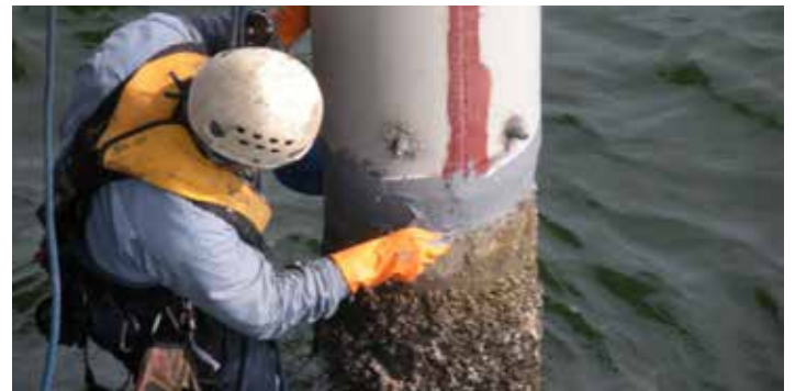
Adhésion pull-off sur de l'acier doux de 10 mm d'épaisseur
