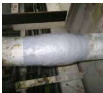
Enveloppement et réparation par plaques
