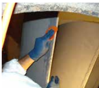
Moulage et reconstruction
