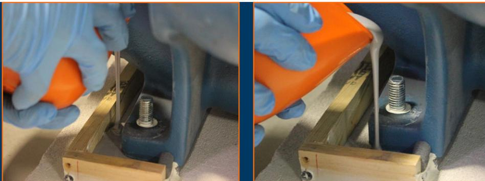
Le Belzona 7111 peut être facilement coulé sans utiliser de résine supplémentaire et sans risque que des particules se déposent avant son temps de durcissement.
