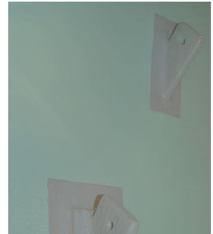
Les couleurs très claires du Belzona 1523 permettent une inspection visuelle facile des cuves. Ce revêtement peut également être testé au peigne électrique de Haute Tension pour détecter les vacances.
