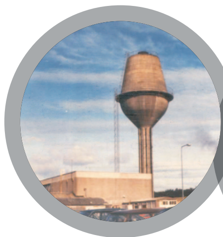
Structures en béton
