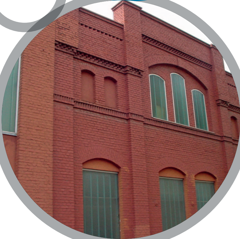
Maçonnerie en brique
