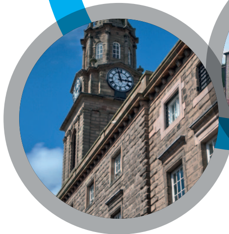
Ouvrages en pierre
