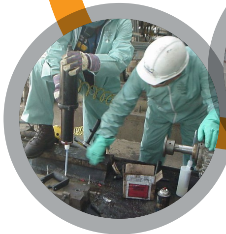
Scellement de plaques de support
