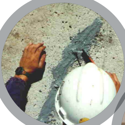
Stabilisation de fissures
