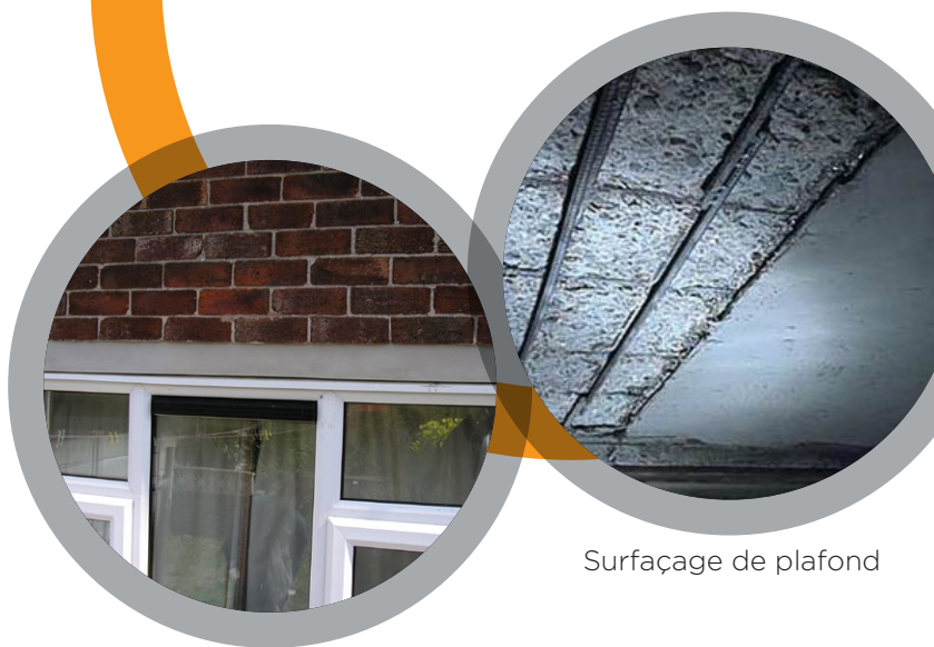
Réparation de linteaux
