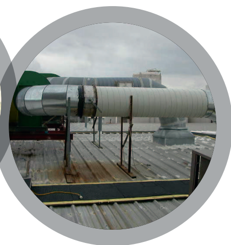
Conduits de climatisation
