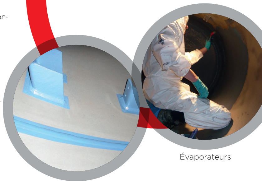
Soudures et supports
