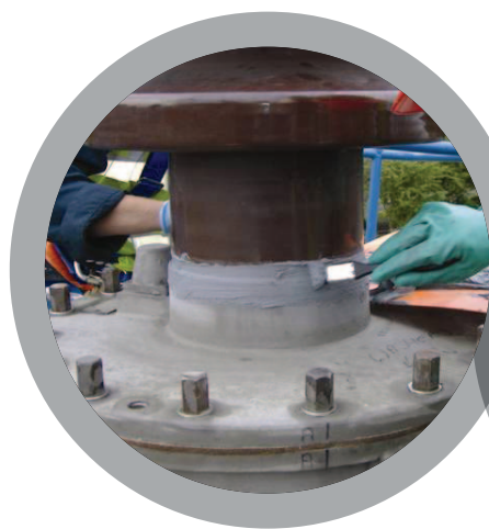
Étanchéité de joints
