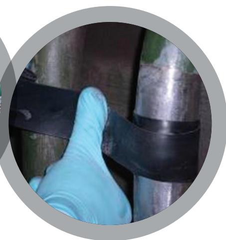
Réparation de fuites d'huile
